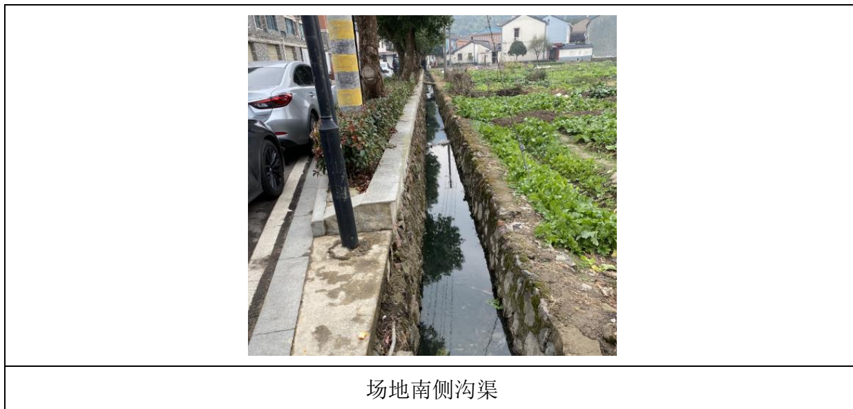
图 2.4-1 地块现状照片（2023 年 11 月）
