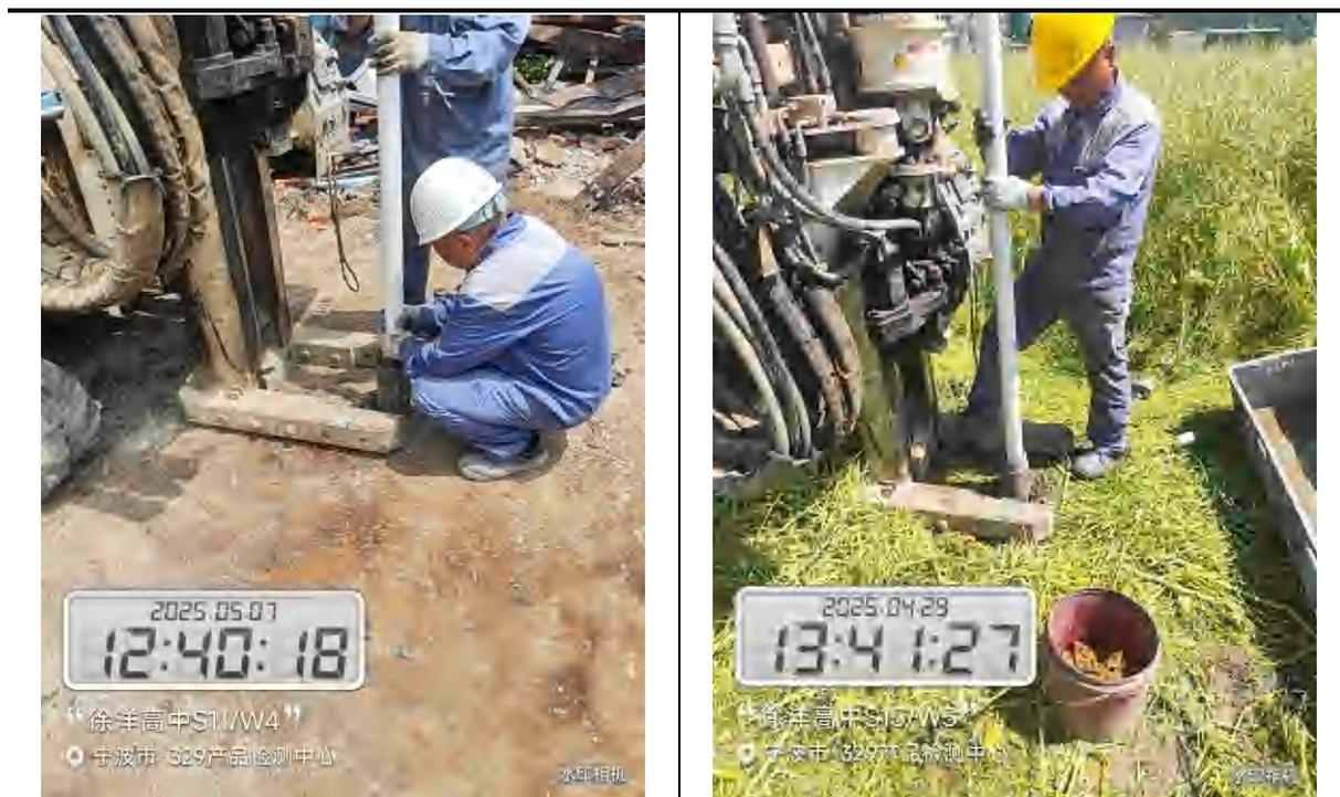
图 5.2-6 地下水监测井下管照片
