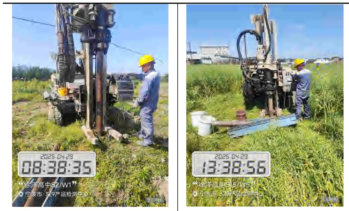
图 5.2-5 地下水监测井钻孔照片
