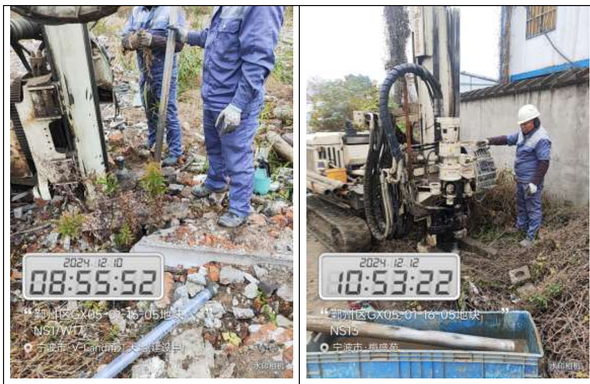
图 7.2-2 土壤现场钻孔取样情况
