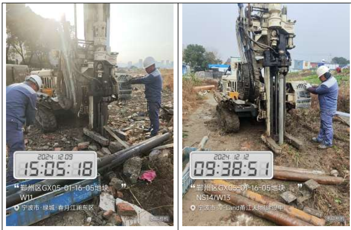
图 7.2-6 地下水监测井钻孔安装照片
