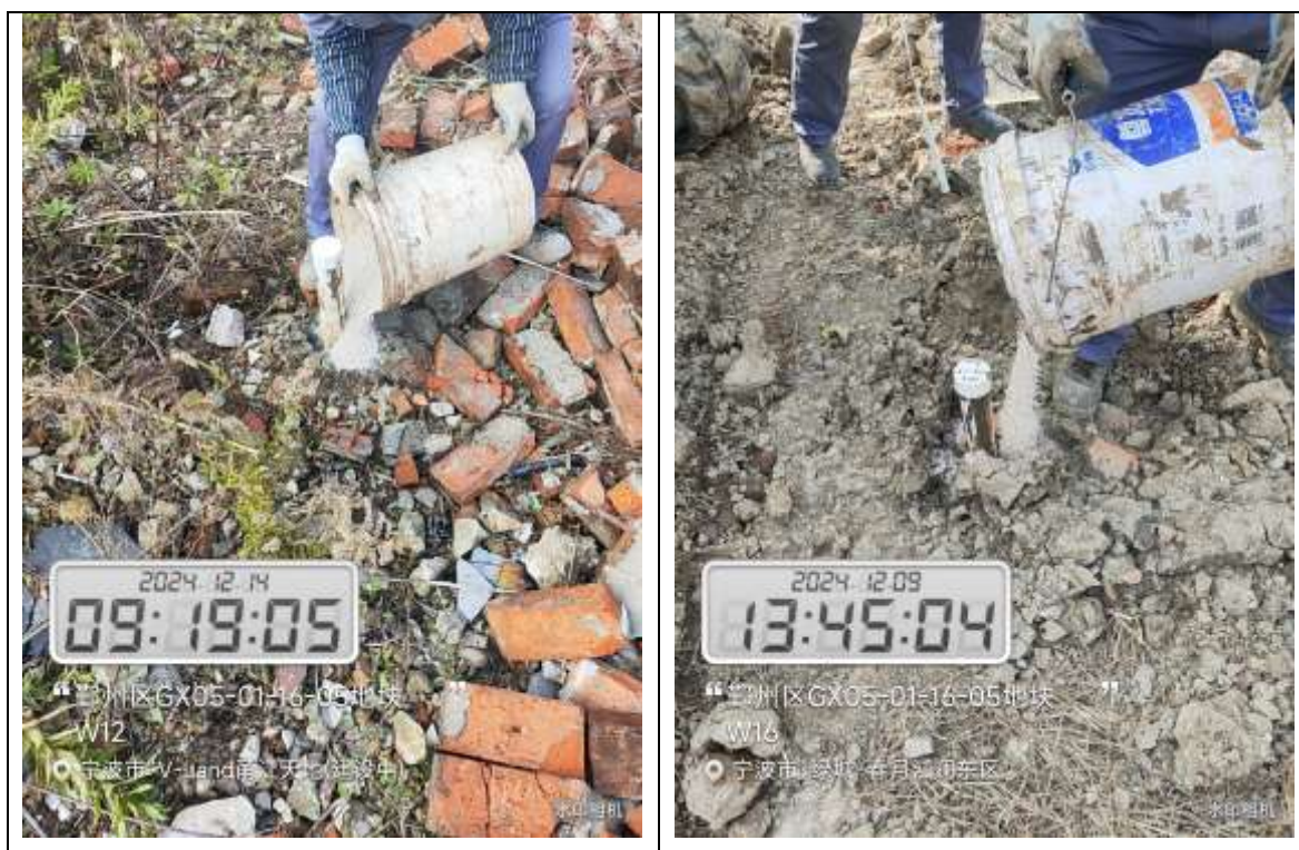
图 7.2-8 地下水监测井填充滤料照片
