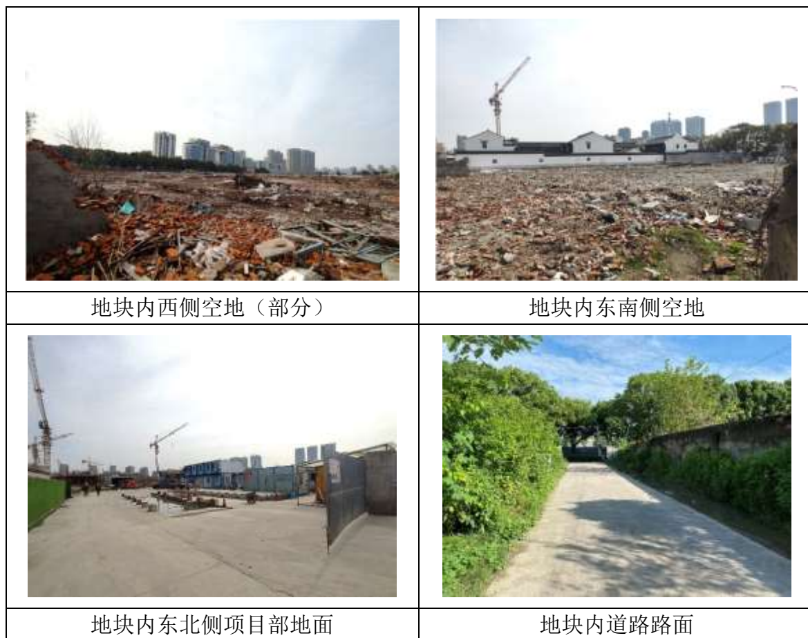
图 3.3-8 场地内地面情况
