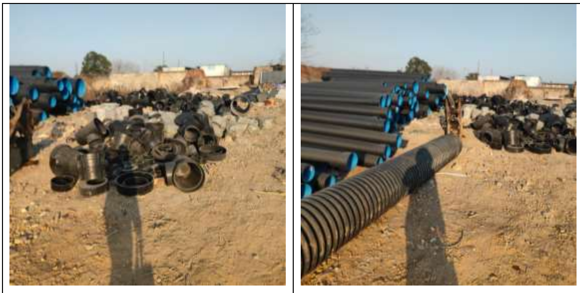
图 7.3-2 地块现场施工材料堆放
