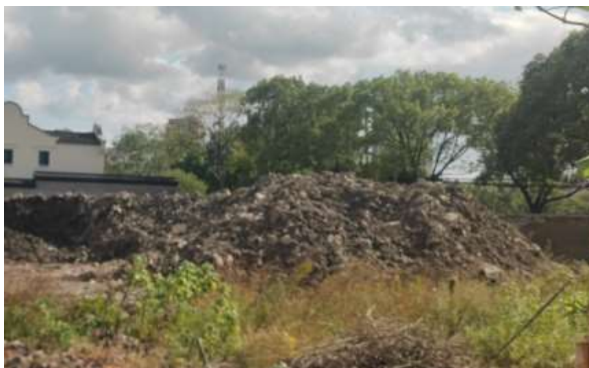
图 7.3-5 现场堆土照片
