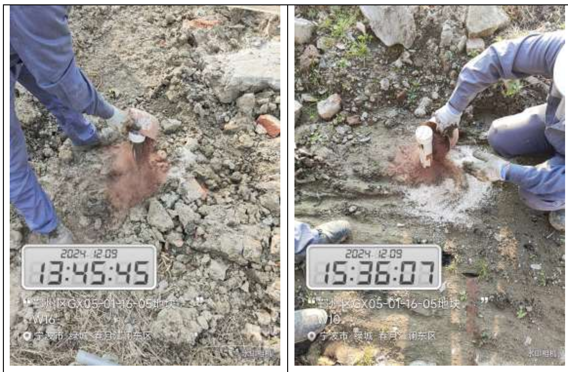
图 7.2-9 地下水监测井密封止水照片
