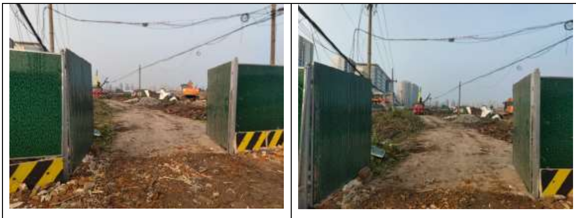
图 7.3-1 地块南侧红线外道路施工照片
