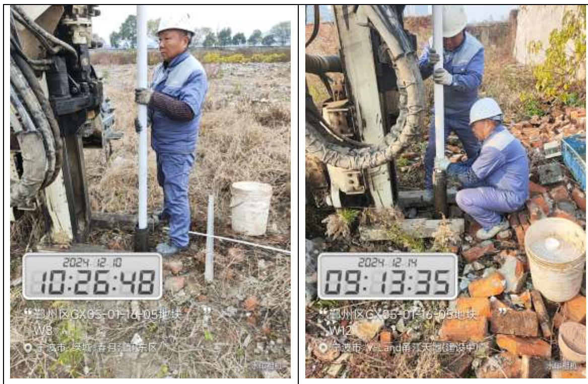
图 7.2-7 地下水监测井下管照片
